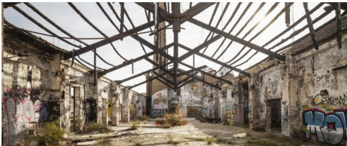
Estat de la fàbrica abans de la rehabilitació.
